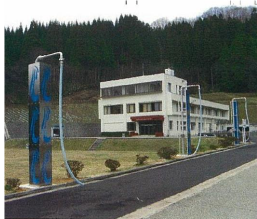
写真 2 子撫川浄水場緊急用給水車給水口
