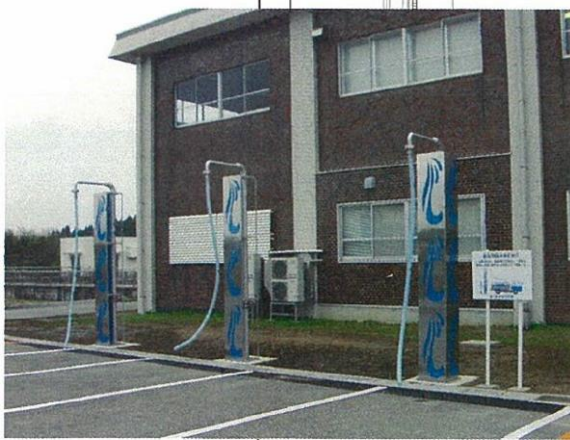
写真 1 和田川浄水場緊急用給水車給水口
