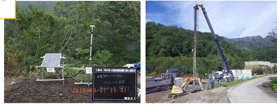
掘削現場から200m離れた地点 (G-2)
