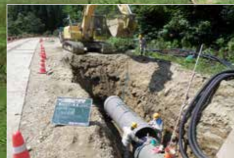
内径1.0mのFRPM管を市道に埋設
