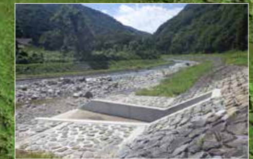
発電に使用した水を河川に戻す水路
