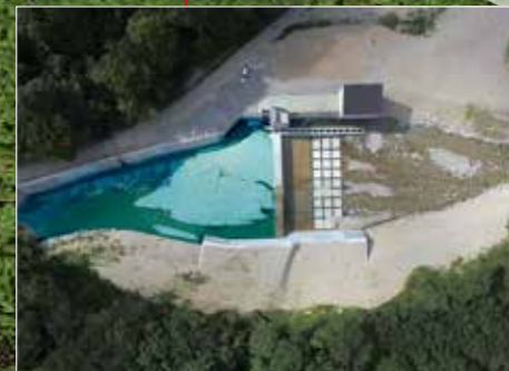
新たに取水堰を設け、維持放流用魚道・沈砂池・除塵機などを整備
