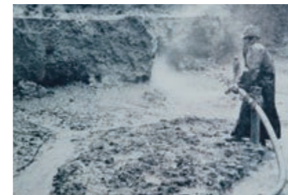
流水客土採掘現場(黒部市教育委員会提供)
