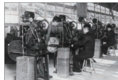
ファスナーの歯を自動的に植え付けられる高速自動植付機 (チェーンマシン)
