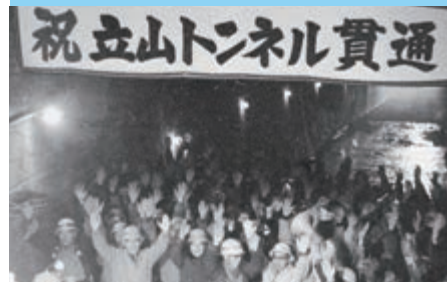
立山トンネルの貫通を喜ぶ人々たち。室堂から大観峰を結ぶこのトンネルは、トロリーバスで通ることができます。(立山黒部貫光提供)
