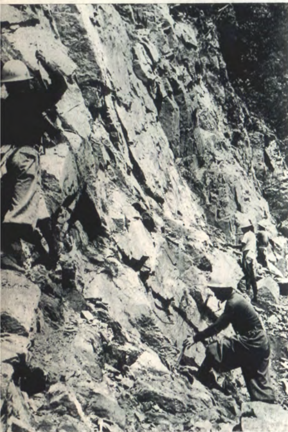
林道の工事も森林資源の開発には不可欠です
