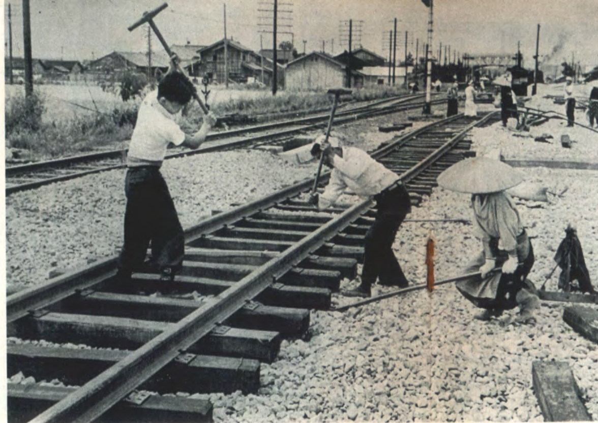
県下各地で複線工事が続けられている
