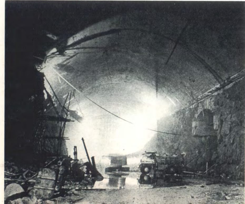
全地下式の黒部川第四発電所の建設現場（関西電力）
