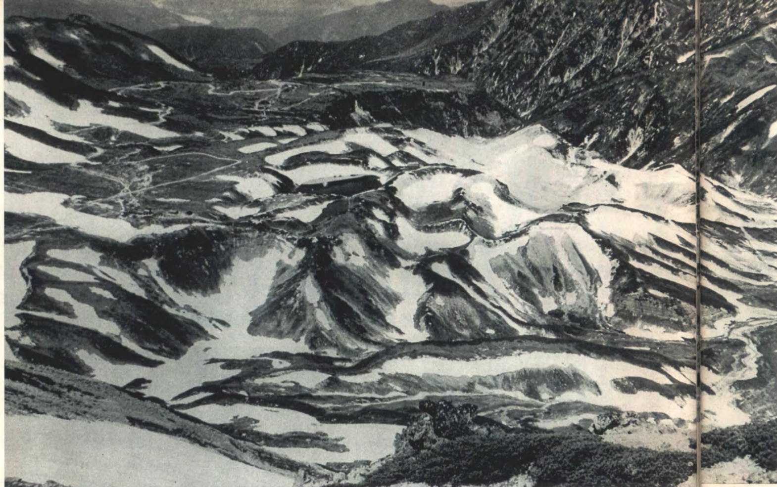
弥陀ヶ原を縫って走る自動車道路、新しい道路は地獄谷を通過して立山トンネルへ入る
