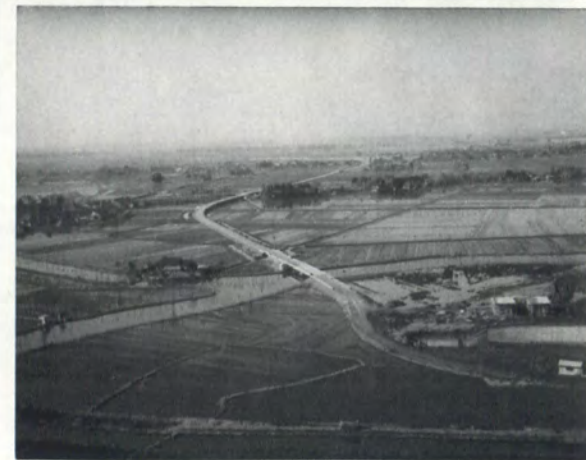
完成した新港う回道路
