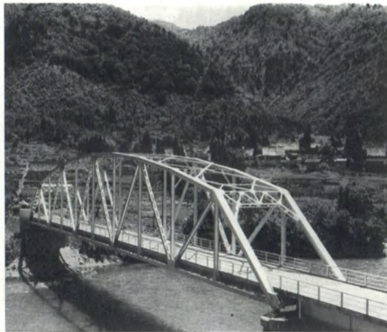
奥地開発に一役をかう永久橋（上平村新屋橋）
