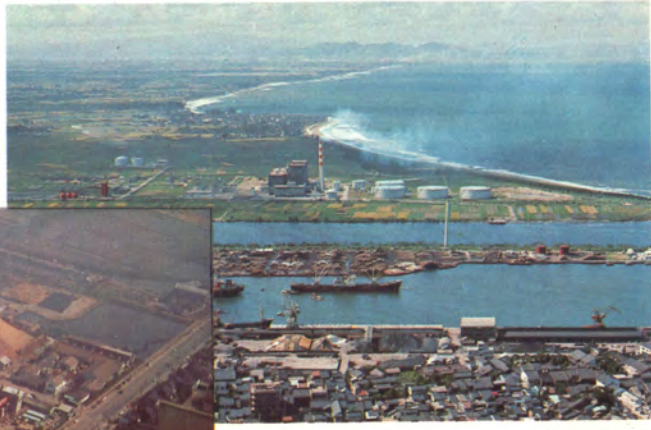
北陸電力K.Kの火力発電所
