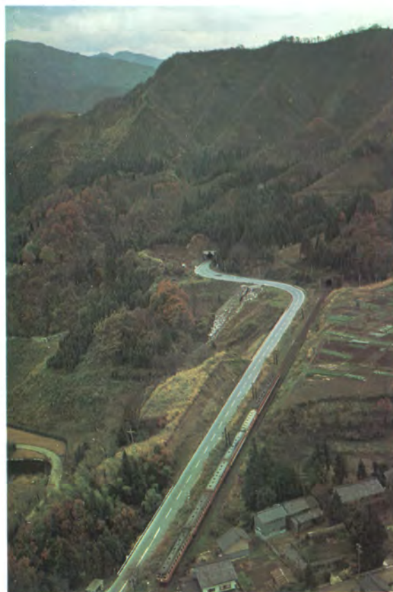
▲ 中部を結ぶ国道41号線と高山線も整備されました
