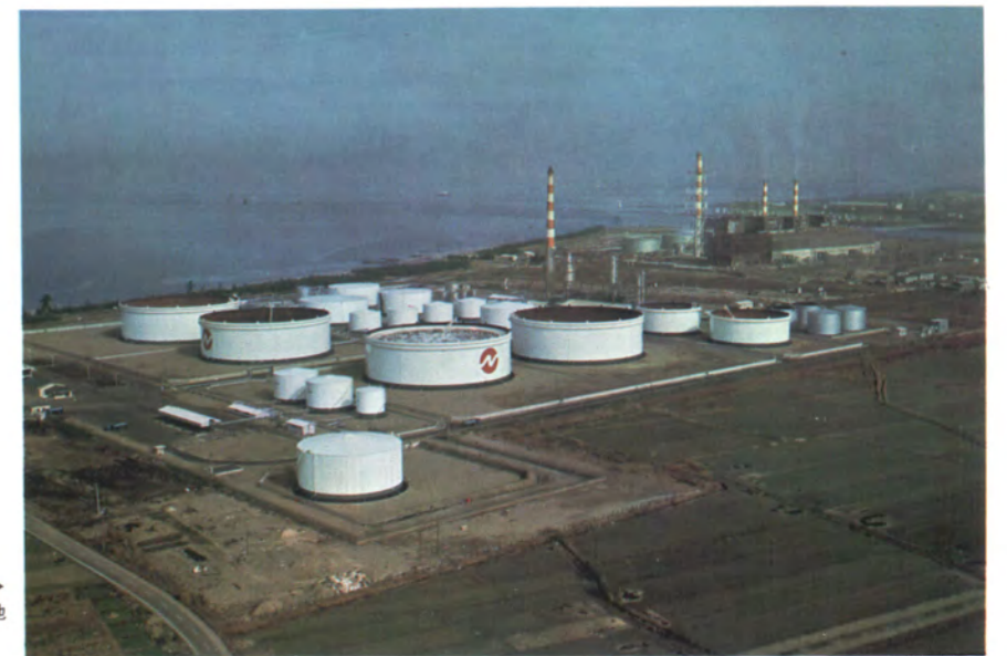
▶ 巨大なタンクが並ぶ日本海石油基地 (隣りが火力発電所と富山港)
