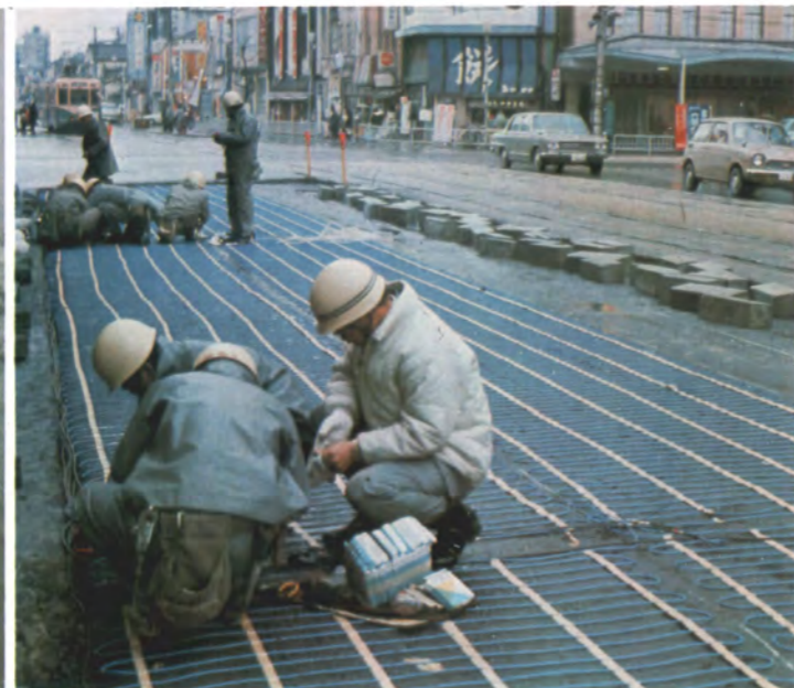
▲これでもかと 電気ヒーターを路面下に
