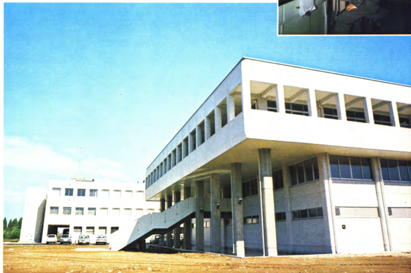
▲近代設備をほこる公害センター（小杉町太閤山）
