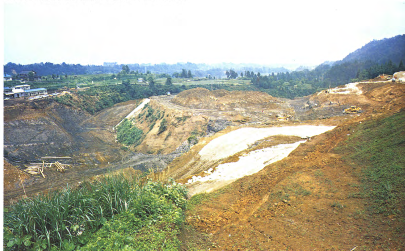
▼立山町などの上水を確認する白岩川ダムは県下初のロックヒルダムになる
