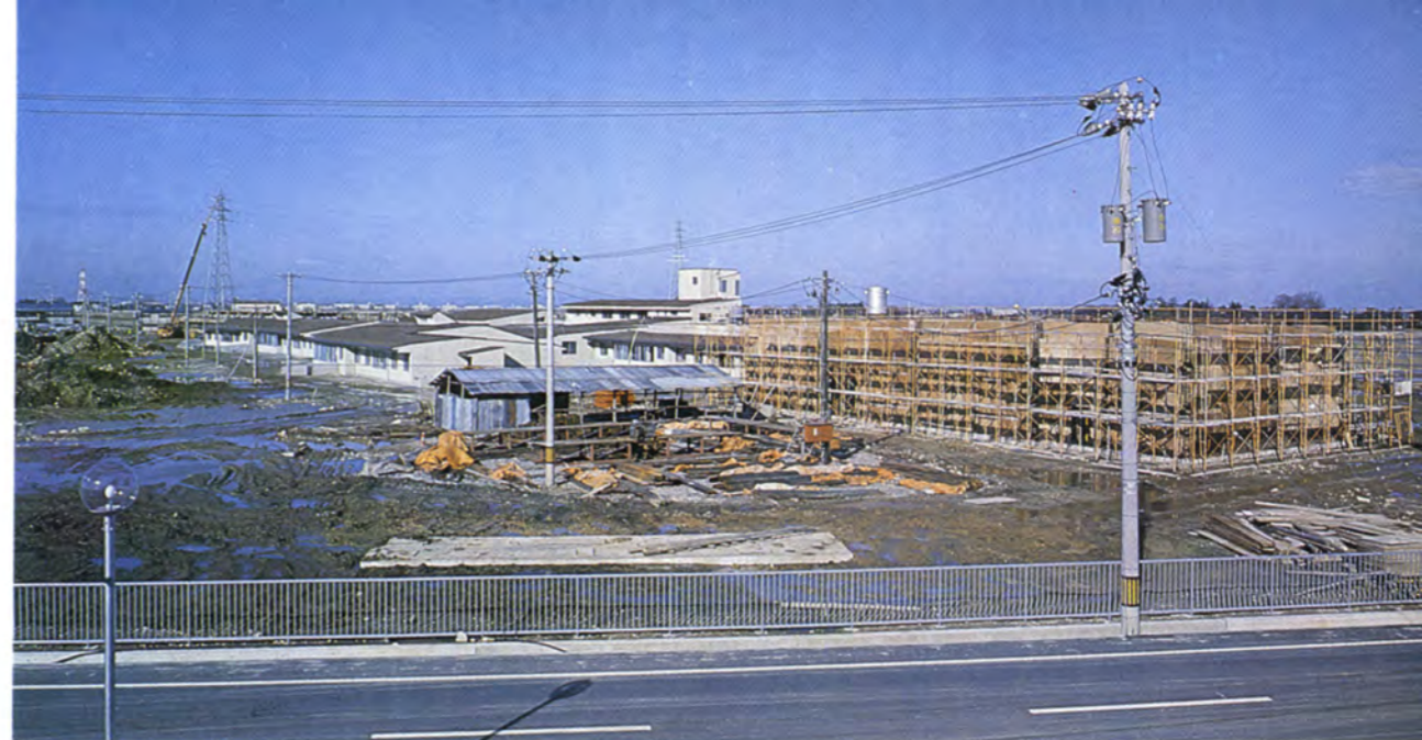
総合福祉センターは まず肢体不自由児施設の建設に着工 急ピッチで工事は進められる
