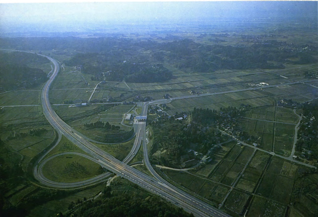
北陸自動車道の整備に伴う物流流通コスト低減と物資の安定供給を図る流通業務団地を小杉インターチェンジ付近に建設
