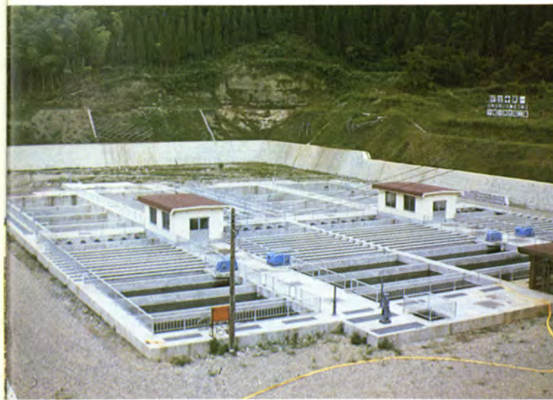
高岡 小矢部 氷見 福岡の市町に 上水道を送水する子撫川浄水場
