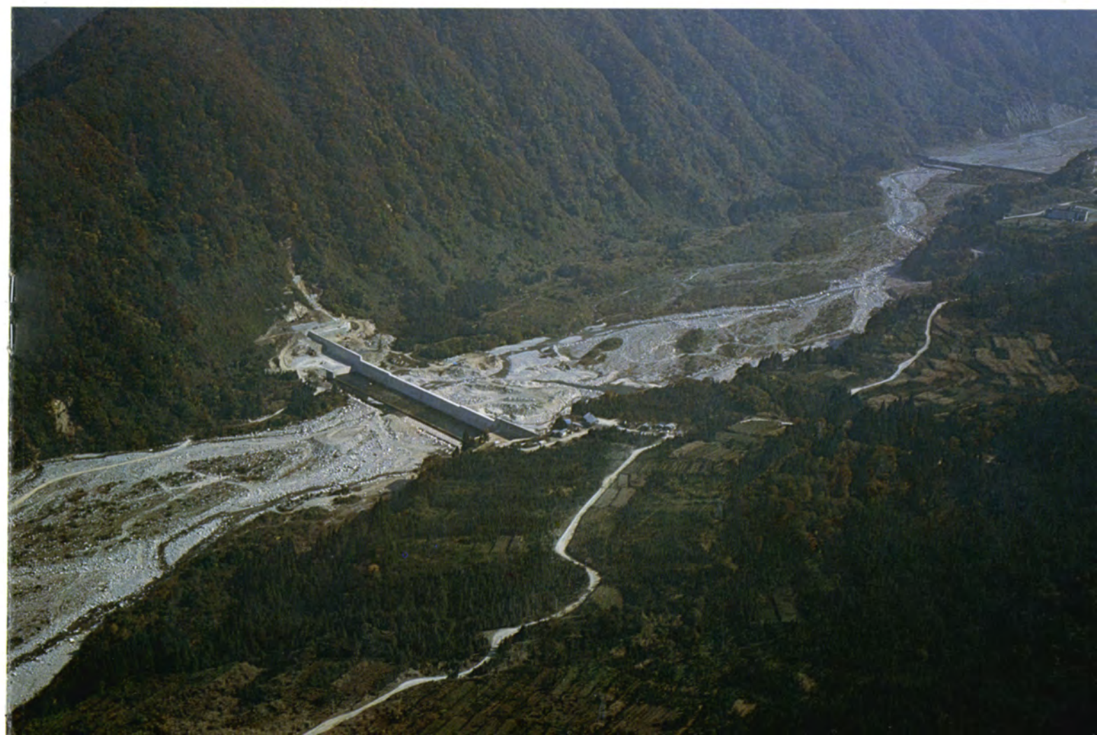
早月川に完成した 堤長日本一の高島砂防ダム
