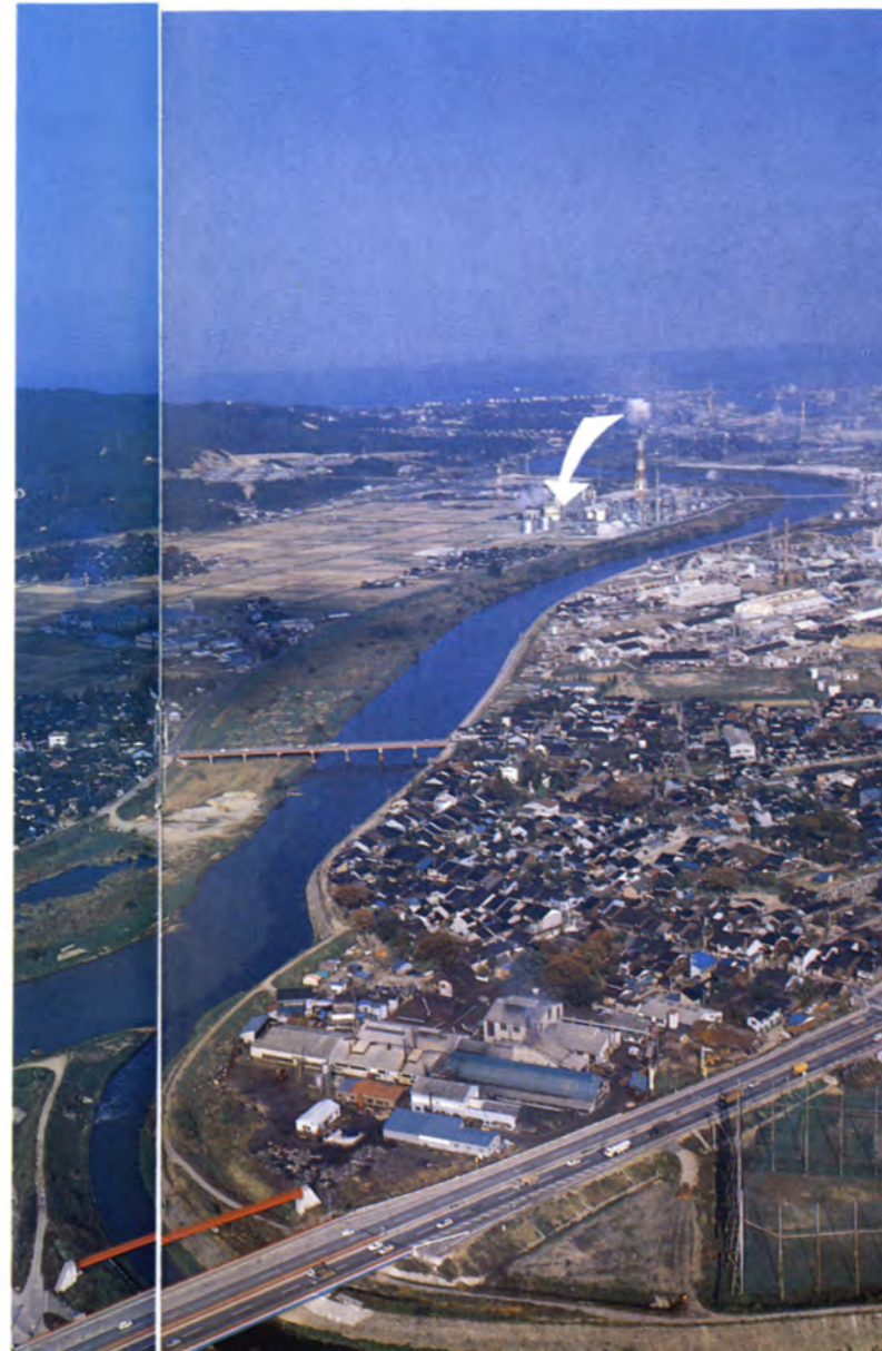
地元の人たちをはじめ関係者の協力と努力で着工される小矢部川流域下水道浄化センターなど建設附近(矢印)
