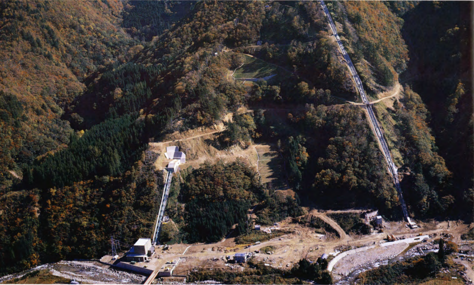
昨年12月21日完成した泉堂大長谷発電所 最大出力8万kW 地域エネルギー源として約4.6%上流の砂防 電気事業併用の猿越 ダム(右下の写真)から導水管で水を引く 流れ込み方法
