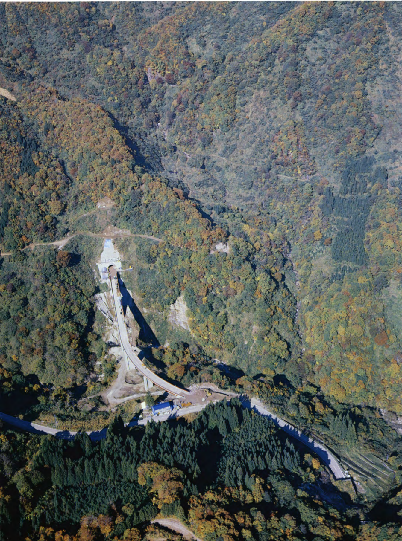
山村振興の要はまず 交通網の整備からと近代工学を駆使して出来上った梨谷大橋と工事中の五箇山第2トンネルの入口=上平村=
