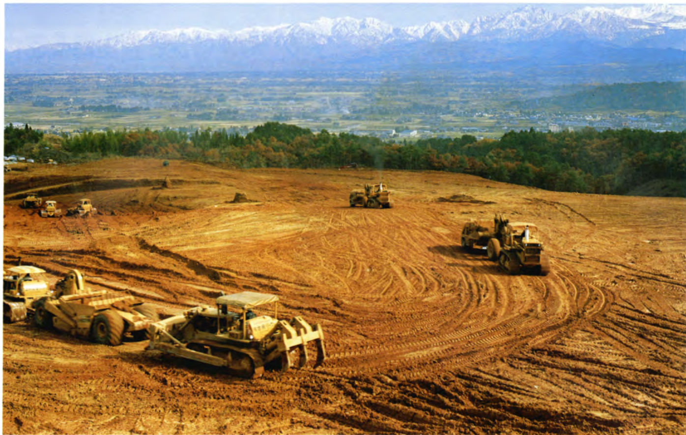
内陸工業団地の拠点となる富山八尾中核工業団地はいま 急ピッチで造成中 58年から分譲開始
