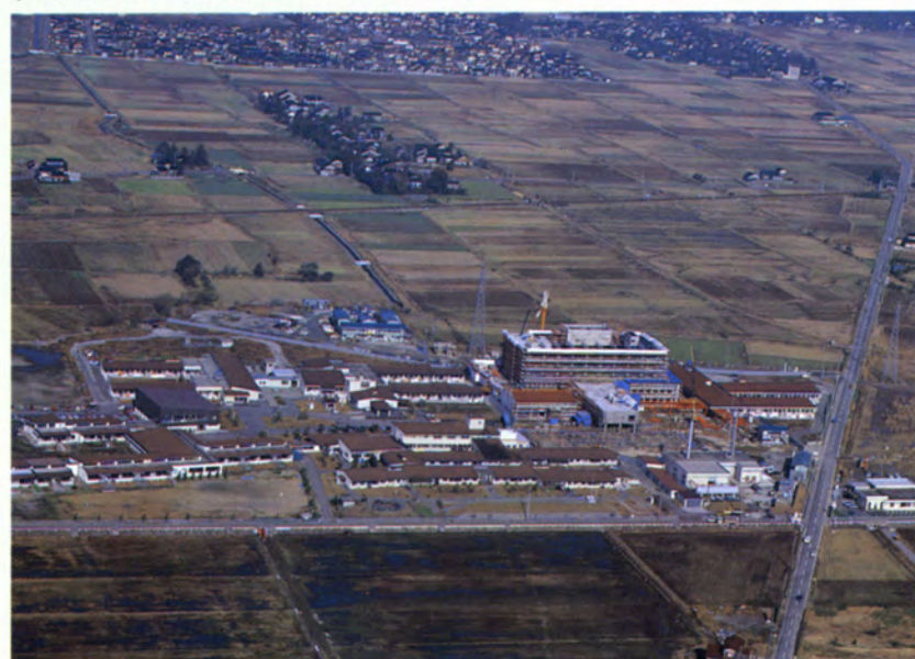
10月の開院をめざす日本海側初の総合リハビリテーション専門病院が急ピッチで建設される社会福祉総合施設センター
