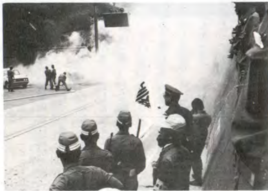
倶利伽羅トンネル出口でトンネル火災消化訓練
