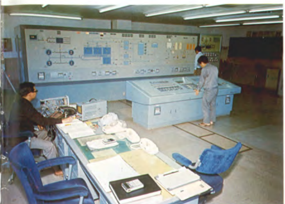
水質や沈でんろ過薬品注入配水など上水・工水の浄水場の水の流れを集中管理する いわば管理所の心臓部
