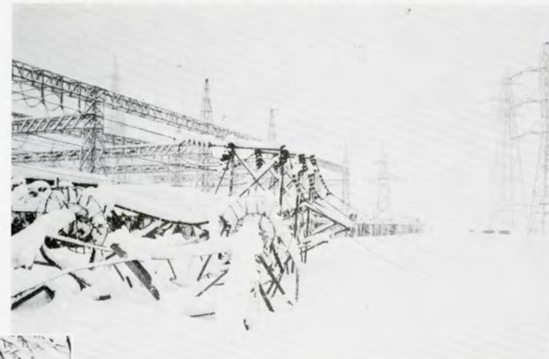
電力県富山の象徴ともいべき高压鉄塔は 雪けむりを上げながら崩れ落ちた
