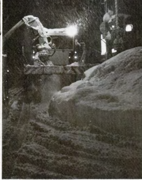
連日連夜除雪車は休む間もなく出動し基幹道路の確保にあたった
