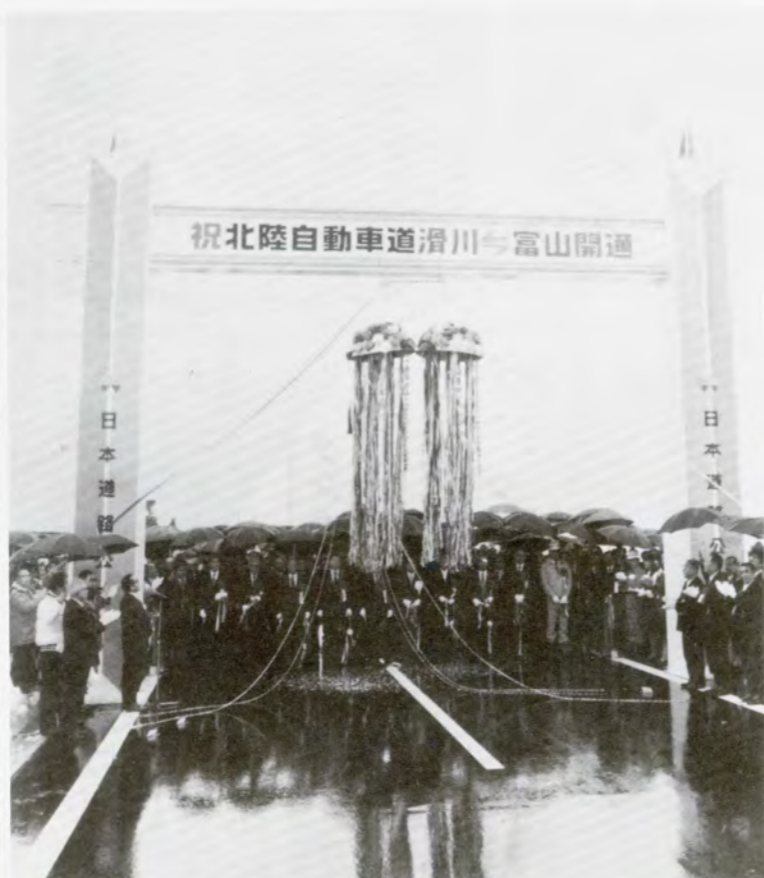
滑川インターチェンジでのテープカット
