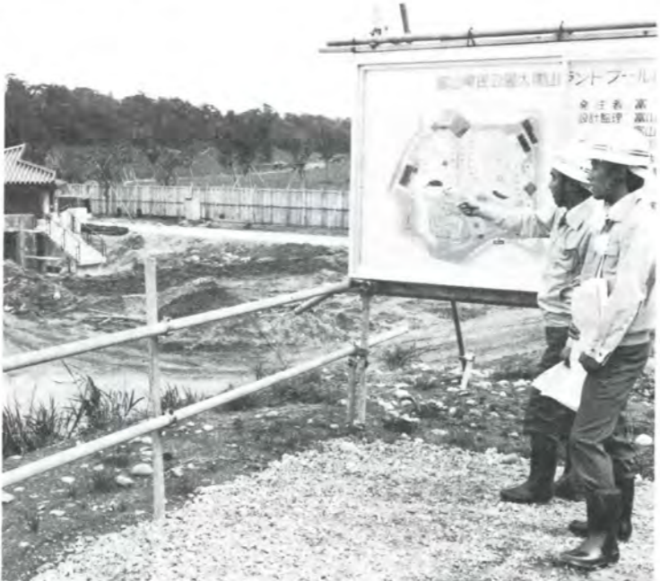
急ピッチで建設が進む県民公園太閤山ランドを視察する
