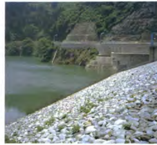
入口は角川ダム
