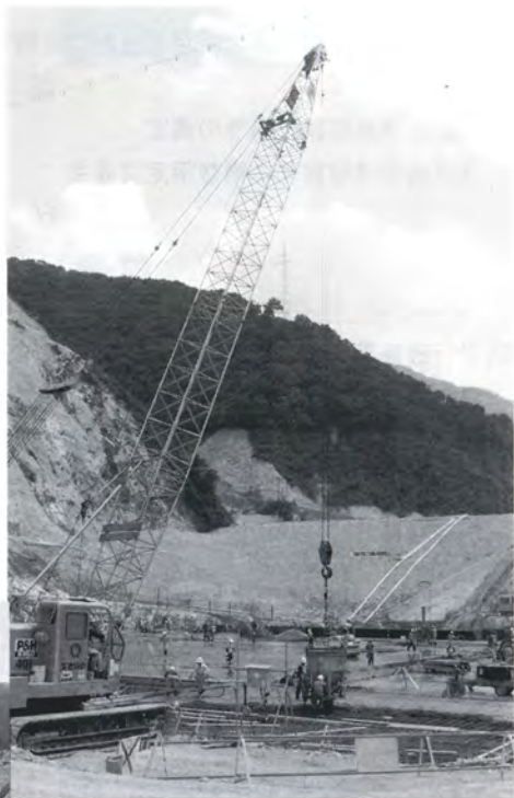
コンクリート打ち
