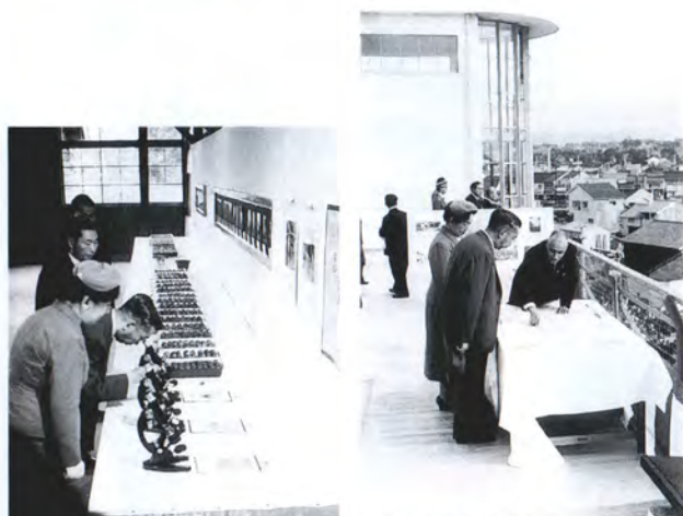
村木小学校屋上 災害復興状況をご覧に (10.20)
