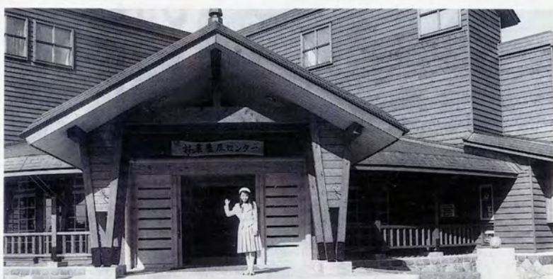
▲林業普及センター
