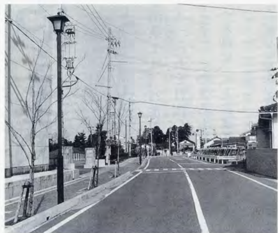
▲ふるさと創生基金で設置された水銀灯
