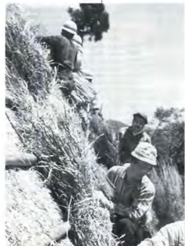
▲屋根の葺き替え体験
