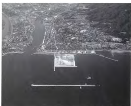
▲整備が進められる伏木外港
