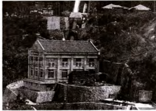
県営発電事業で建設された最初の発電所のひとつ松ノ木発電所(上)と中地山発電所(下)。現在は北陸電力の発電所として、当時の建物のまま使用されている。
