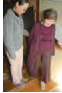
改修先の使い勝手を確認する雄川さん（左）。玄関の段差部分に一段低いステップと手すりを設けた。
