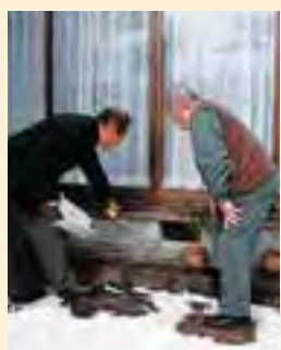
木造住宅の耐震診断における基礎の状況調査
