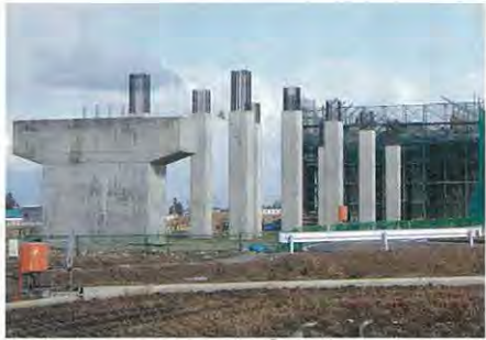
北陸新幹線工事
