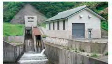
農業用水を利用した小水力(白中発電所)
