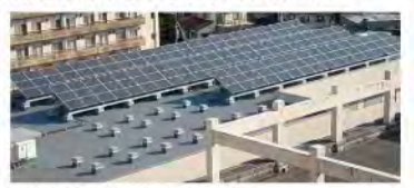
中央病院新東病棟 太陽光発電
