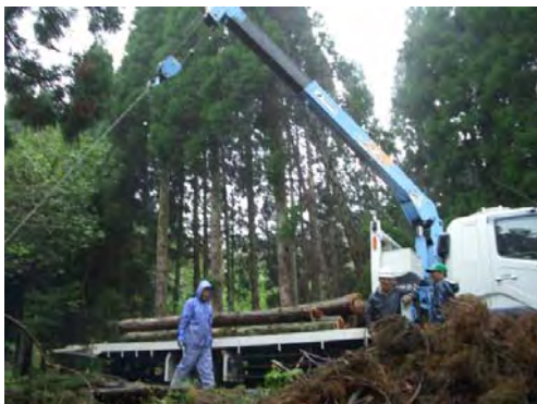
支障木の処理
