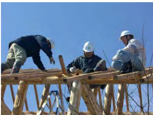
県産材休憩小屋建設状況
