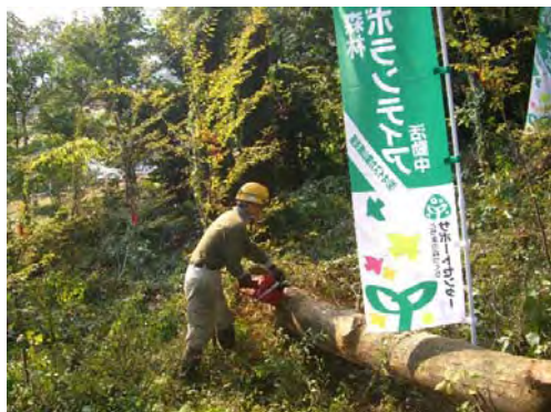
支障木の処理
