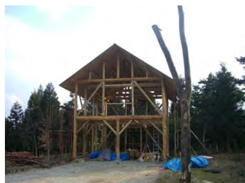
休憩小屋完成
