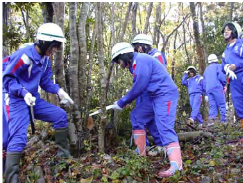
支障木の処理
