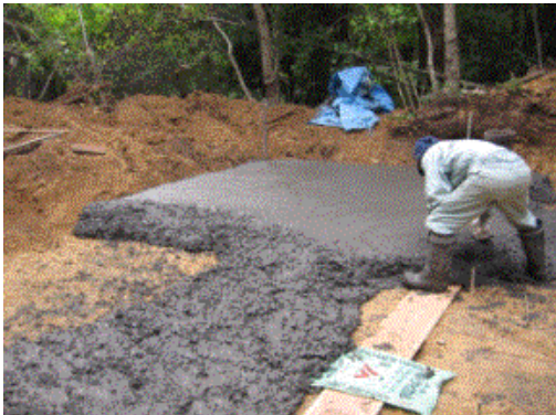
炭窯づくり（窯底生コン打設）
