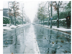
下水処理水を利用した消雪パイプ (県道富山魚津線富山市浜黒崎)
