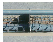
消雪パイプへの塩ビ管使用
