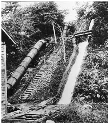
大久保発電所（『富山県写真帖』より）
