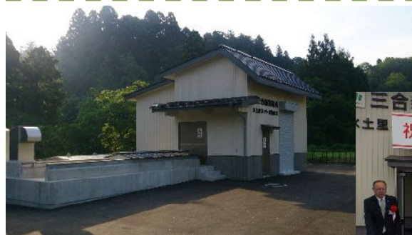
発電所の外観
