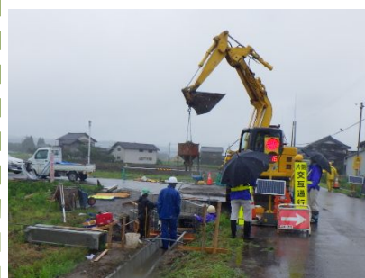
コンクリート打設状況
