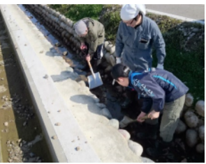
＜水路の江浚い＞
