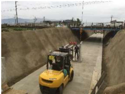
フォークリフトによるL型水路壁の布設
