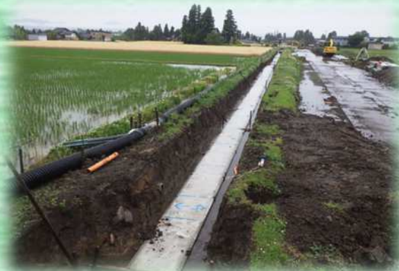
施工中(仮設水路)
