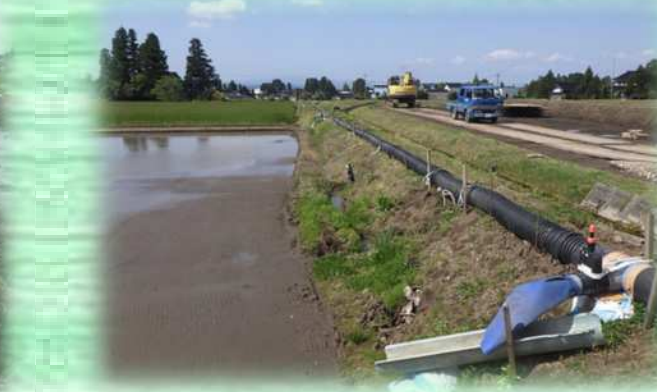
施工中(仮設水路)
