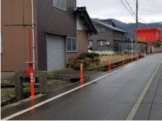
道路と用水路の境目にポールコーンを設置 (セミハード対策)
