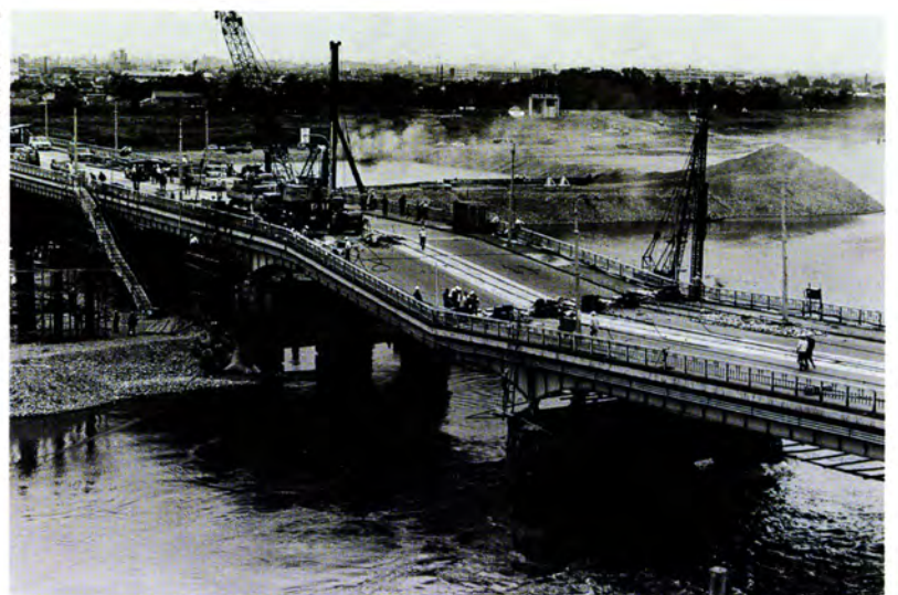
富山大橋西詰の橋脚沈下 昭和四十四年七月二日、神通川大増水、V字形に陥没 水橋の浪害 昭和十年十一月十二日、富山に寄り回り波襲来
