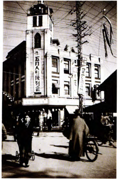
岡部呉服店 県内初の三階建洋館。富山市中町 (中央通り)角に大正十二年にできた。
