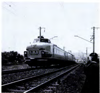
複線電化が完成 北陸線富山駅付近
