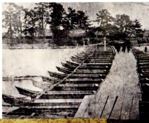
五箇山の鉄鎖吊橋 明治八年、下梨と大島間の庄 川に架けられた吊橋
