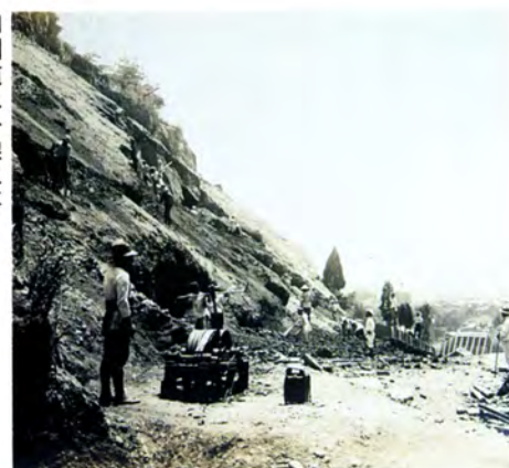
旧国道八号線工事
