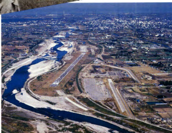
改修中の富山空港
