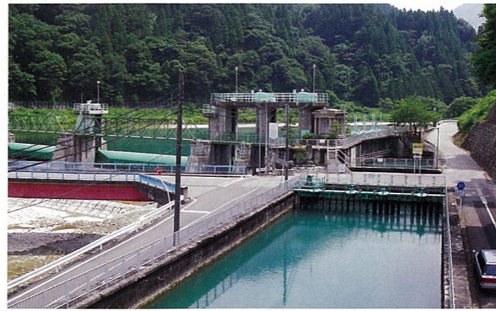
衰輪堰堤（頭首工）
