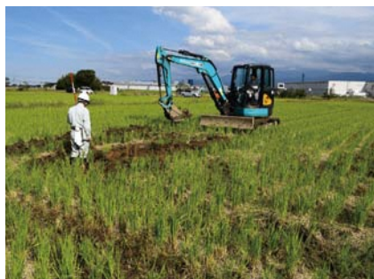
試掘調査でのトレンチ掘削
