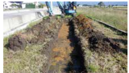
重機でひとかき、穴を確認しました
