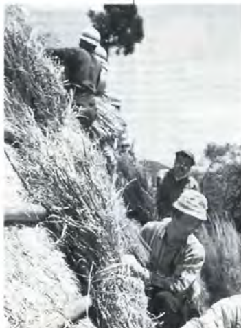
▲屋根の葺き替え体験
