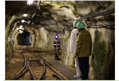
黒部ルートの玄関口：樺平上部軌道トンネル
