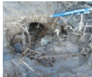
巢穴からの漏水 (涵養実施田)
