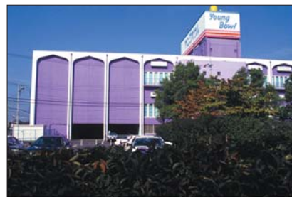
違和感の強い紫色の外観が緑地の緑よりも目立つ建築物—他県事例
