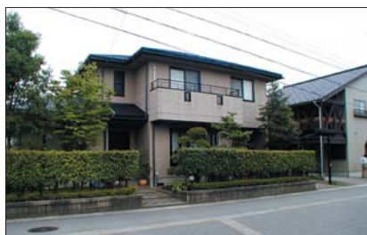
外壁 : 1.0Y5.0/1.5 屋根 : N2.0
