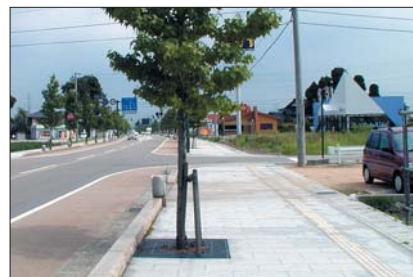
石材の素材色を生かした舗装——砺波市
