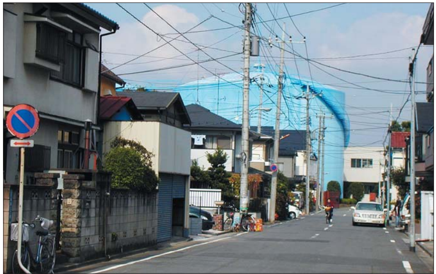
水の連想から水色を採用し、落ち着いた暖色系の町並みに違和感を与えている給水タンク—他県事例
