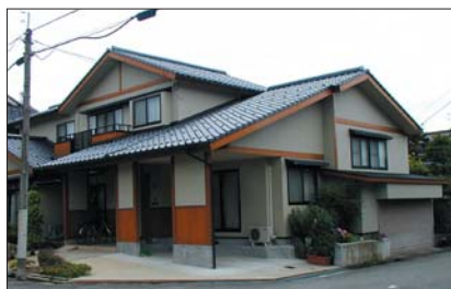
外壁 : 3.5Y6.0/1.5 屋根 : N3.0
