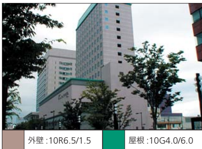
穏やかな対比のストライプパターンを採用した建築物—富山市
